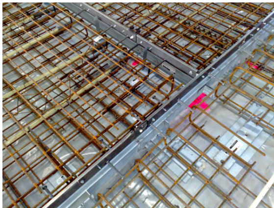
Logistikzentrum Wildenhofer - Bodenplatte
