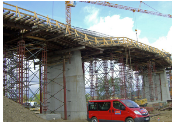
Ausbau der Koralmbahnstrecke – Gussendorf
