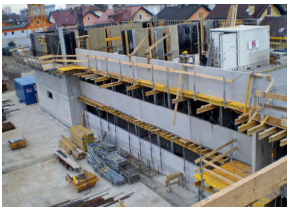
Neubau der Wohnhausanlage Pflanzmanngründe in Salzburg
