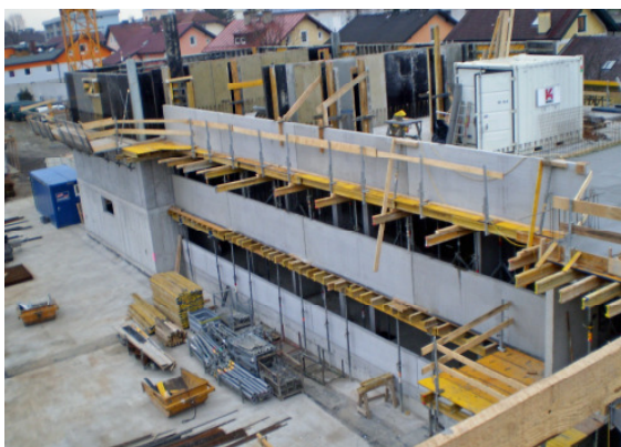
Neubau der Wohnhausanlage Pflanzmanngründe in Salzburg
