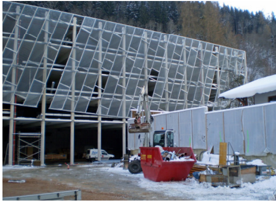
Neubau des Parkhauses Planai – Schladming
