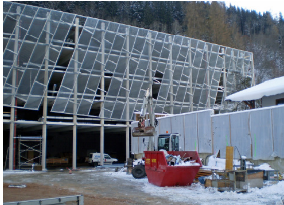
Neubau des Parkhauses Planai – Schladming
