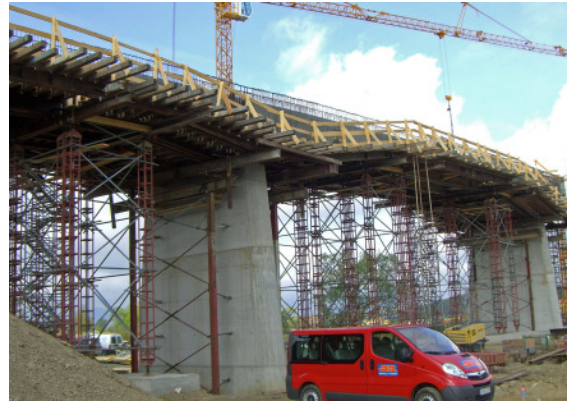
Ausbau der Koralmbahnstrecke – Gussendorf
